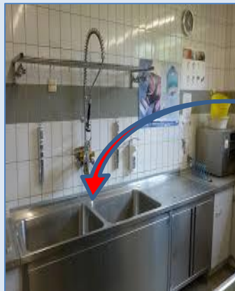
Variante 2: Absaugung hinter dem Reinigungsbecken
